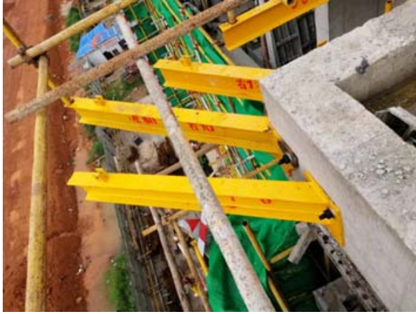
图4 转角位置型钢现场布置
