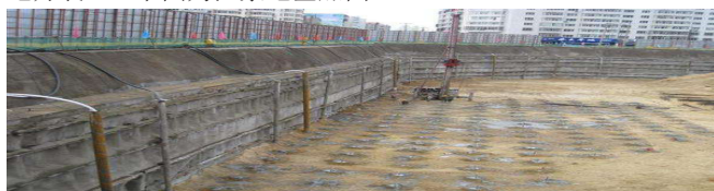
图1 为某企业的地基注浆加固
