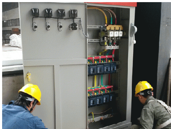
图1 配电箱安装技术
