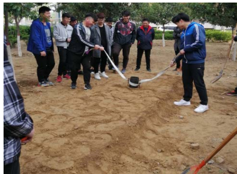
图1 人工夯实路堤填土
