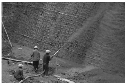
图1 喷锚网支护施工现场
