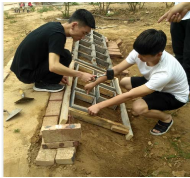
图2 骨架护坡施工
