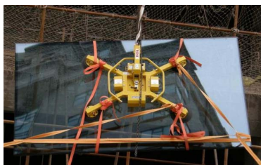
图2 大块玻璃吊装示意图
