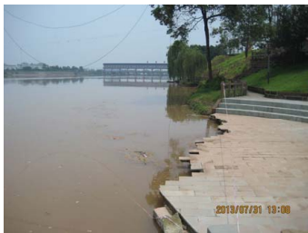
图1 工程水毁照片
