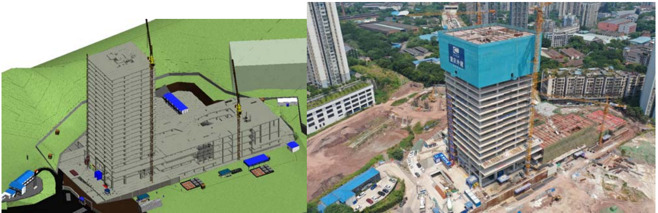
图4 施工场地及临舍
