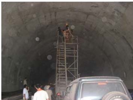
图1 隧道工程质量检测工作图
