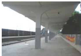
图1 预制装配式钢筋砼板雨棚屋面示意图 图2 原玉林站站台雨棚特点分析:此类型屋面的优点是建造速度快,受气候条件制约小,节约劳动力。其结构体系受列车进出站震动影响,板端头易出现移位,且加固措施工艺烦琐,维修施工难度大。目前有预制装配式钢筋砼板屋面的客站台雨棚现已陆续拆除重建。
