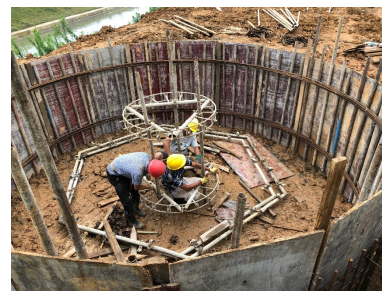
图4 新型的一体式内模支架示意图
