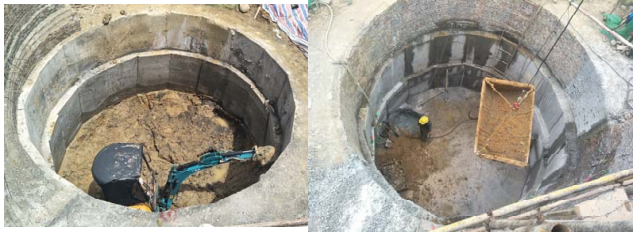
图1 微型挖掘机配合出渣斗施工
