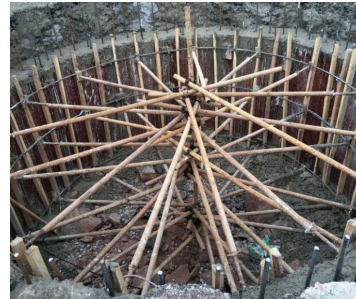
图3 常规的工作井井壁模板支架
