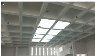
图三 井字梁屋顶与采光顶（作者自摄）
