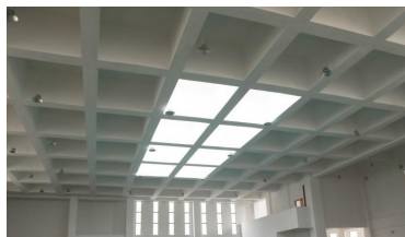
图三 井字梁屋顶与采光顶（作者自摄）
