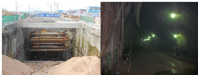
图1-1 地铁项目明挖区施工场地 图1-2 地铁项目暗挖区施工场地
