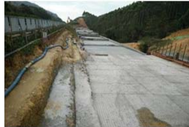
图8 轻质土管道输送
