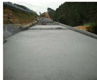
图9 泡沫轻质土浇筑及成型
