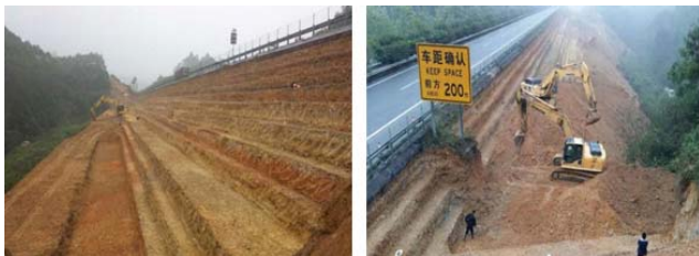
图1 台阶开挖施工现场
