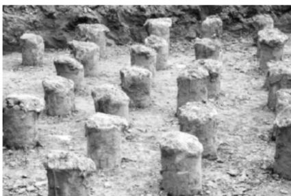
图1 水泥粉煤灰碎石桩处理技术
