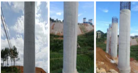
图1 项目生产桥梁立柱外观图
