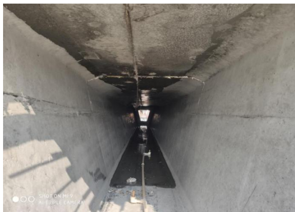
图5-2 小箱梁内模拆除后内腔效果图
