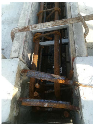
图3 优化后，错开一个钢筋位置
