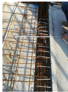
图2 优化后，阳台板预留钢筋50cm
