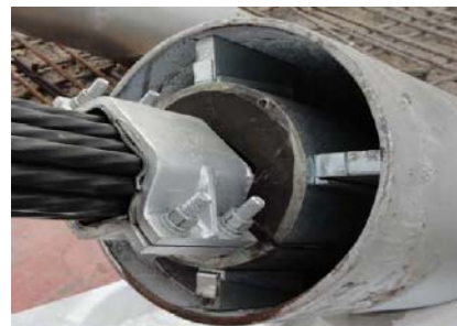
图4 定位器及索夹安装图
