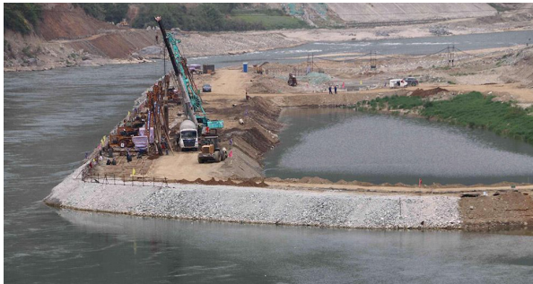
图1 围堰工程项目施工
