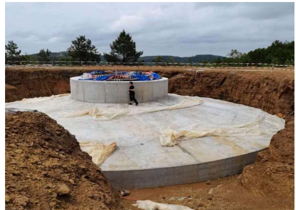
图1 风机基础大体积混凝土
