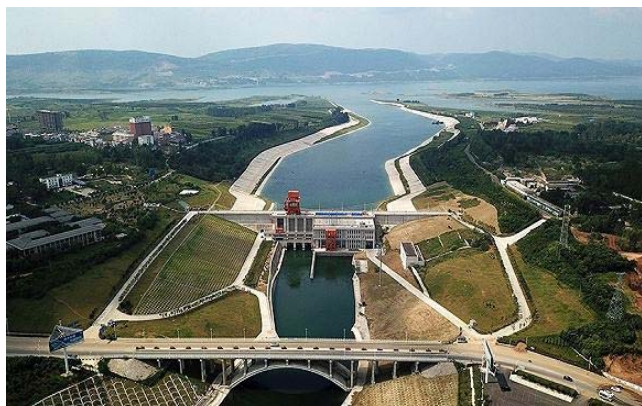
南水北调中线工程渠首闸
