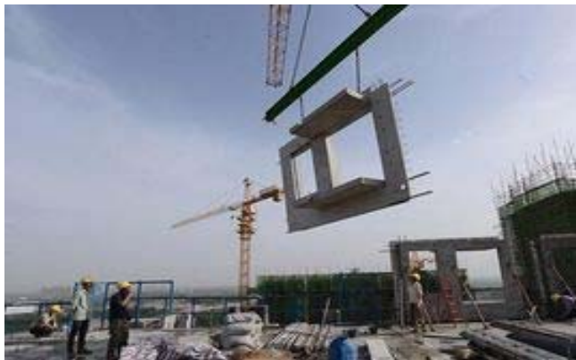
图一 预制装配式住宅建筑
