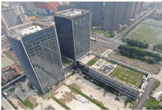
现场施工实景
