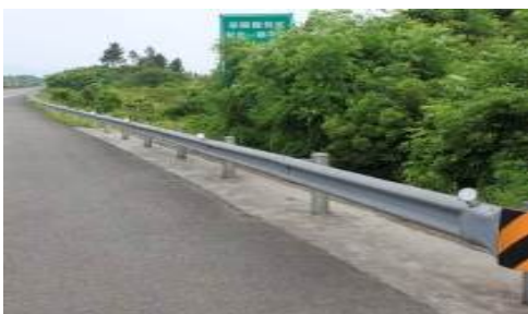
图2 护栏预埋置在路侧示意图
