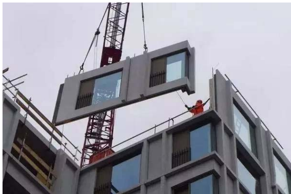
图1 装配式建筑施工现场
