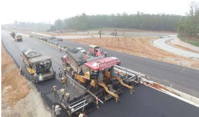
图2 沥青路面摊铺现场施工图
