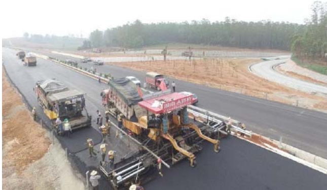
图2 沥青路面摊铺现场施工图
