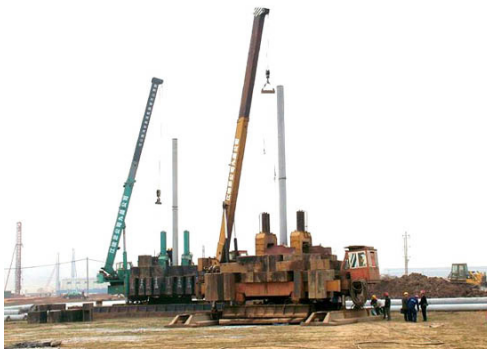
图1 静压管桩施工
