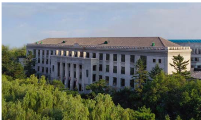
图3 机电学馆改造后的实景照片 来源：作者自摄
