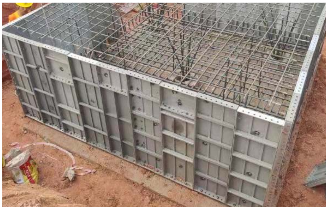
图1 铝模承台施工铝模搭建过程
