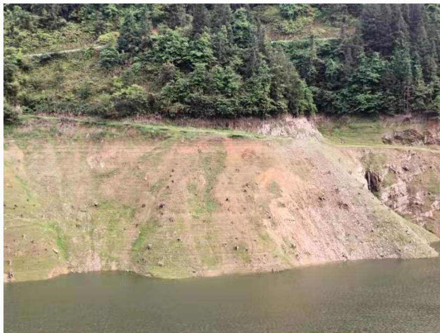
图1 典型岸坡消落带岩体破坏图
