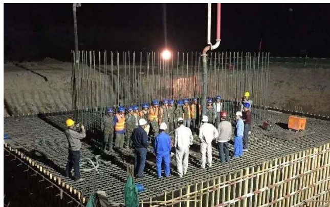
图1 大体积混凝土施工图
