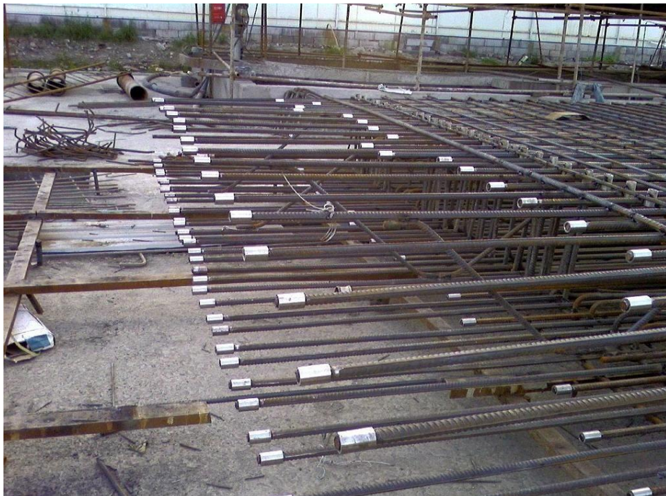
图1 钢筋连接套筒
