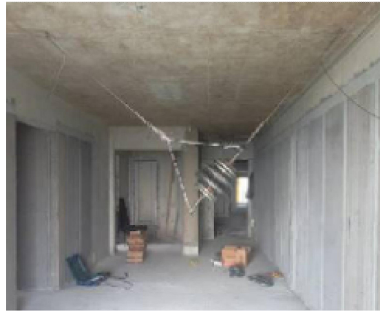
图2 隔墙冲击试验现场
