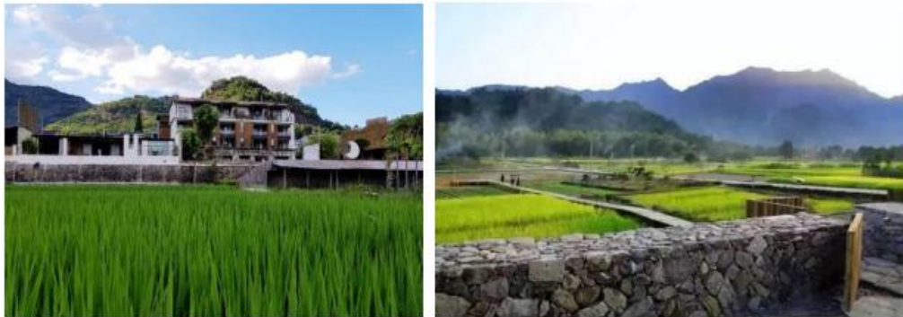
图一 农田基础设施建设
