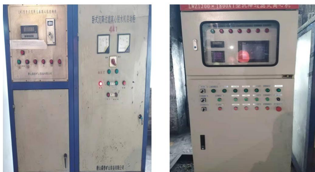
图2 LWZ1200×1800型卧式沉降过滤式离心脱水机自动控制改造(左侧改造前,右侧改造后)
