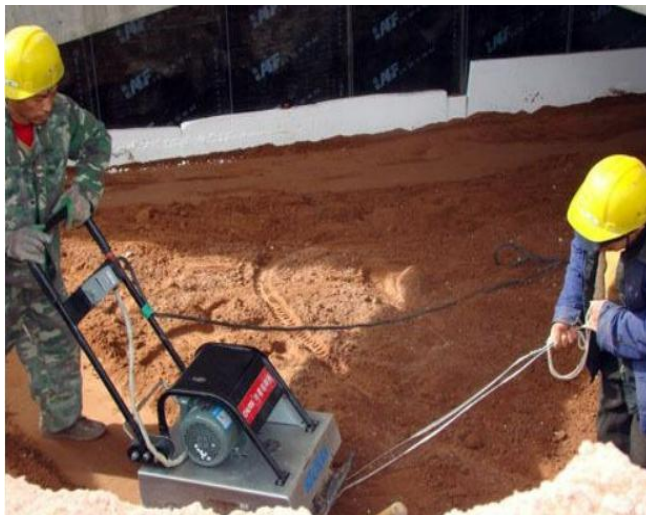
图1 人工回填
