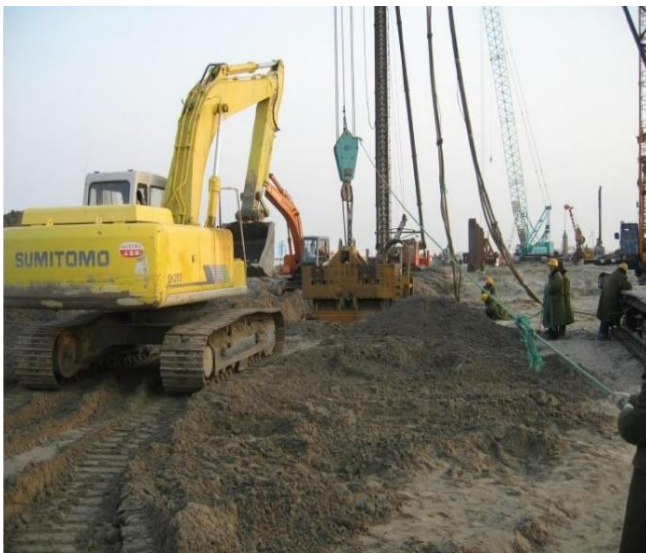
图2 大型机械夯实
