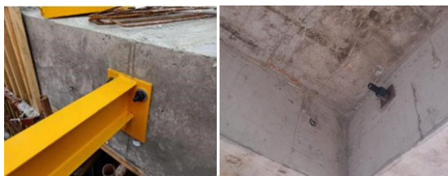
穿墙对拉螺栓拧紧
