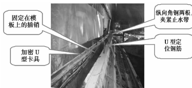
图一(纵向钢边止水带固定工装结构)
