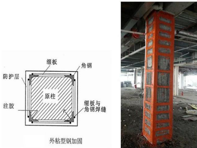
图2 外部粘贴钢板加固
