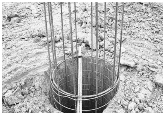
图1 钢筋笼安装下放
