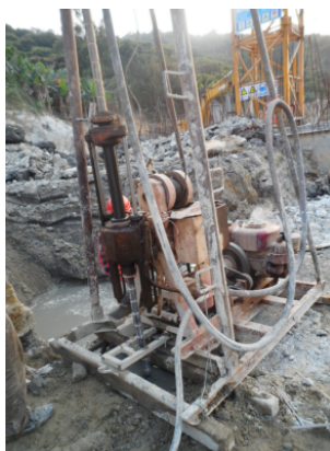
图4 反循环泥浆护壁钻孔
