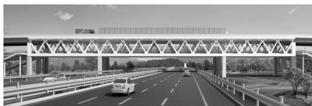
图1 跨沪宁高速公路双层钢桁架桥
