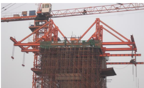
图1 悬臂挂篮的吊装
