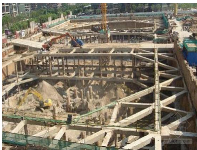
图1 地连墙施工图
