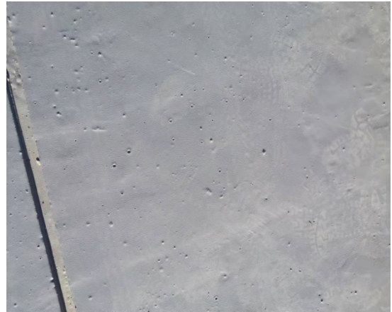
图4 防水漆表面气泡
