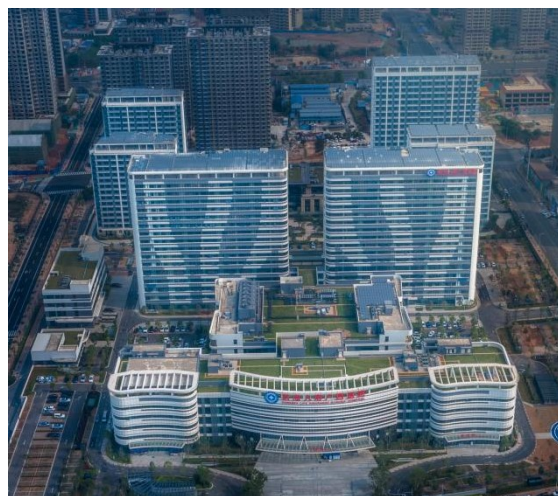
图1 总平面图 竣工实拍照片
